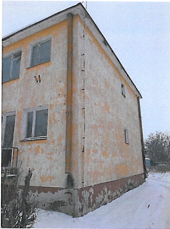
Fot. 3. Elewacja budynku
