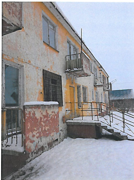
Fot. 2. Elewacja budynku
