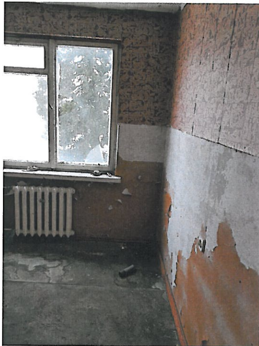
Fot. 4. Stolarka okienna, instalacja c.o.
