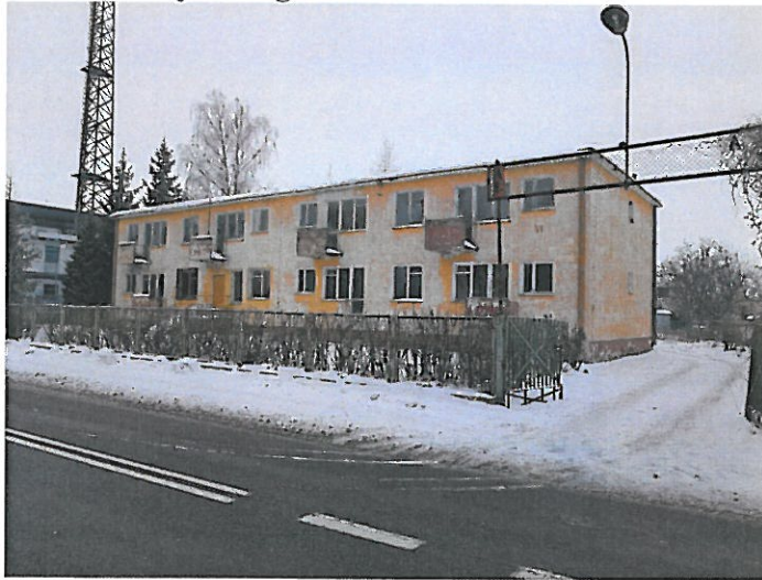
Fot. 1. Elewacja budynku
