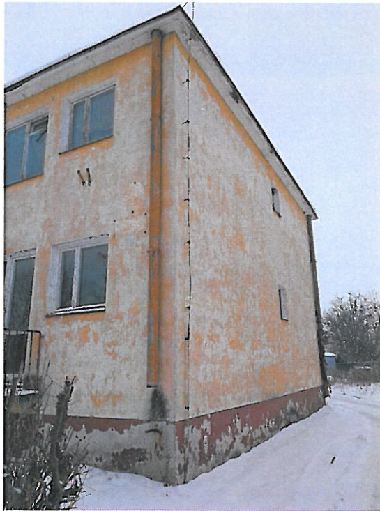
Fot. 3. Elewacja budynku
