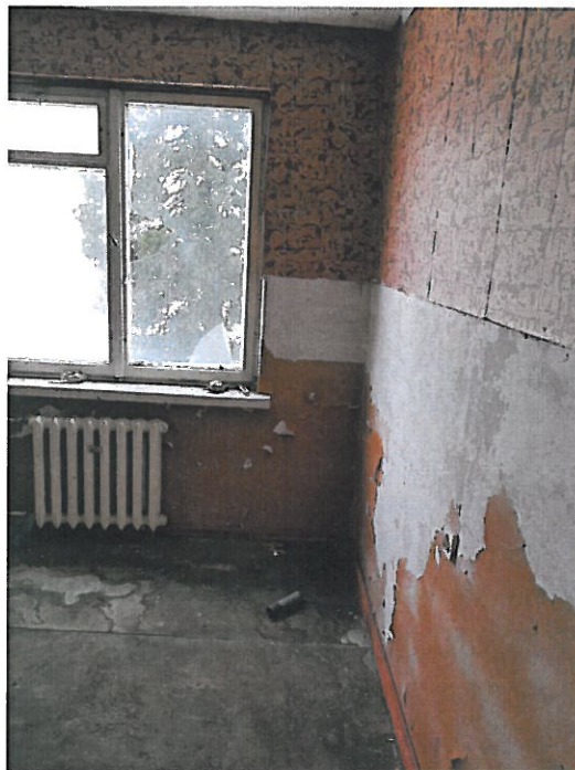
Fot. 4. Stolarka okienna, instalacja c.o.
