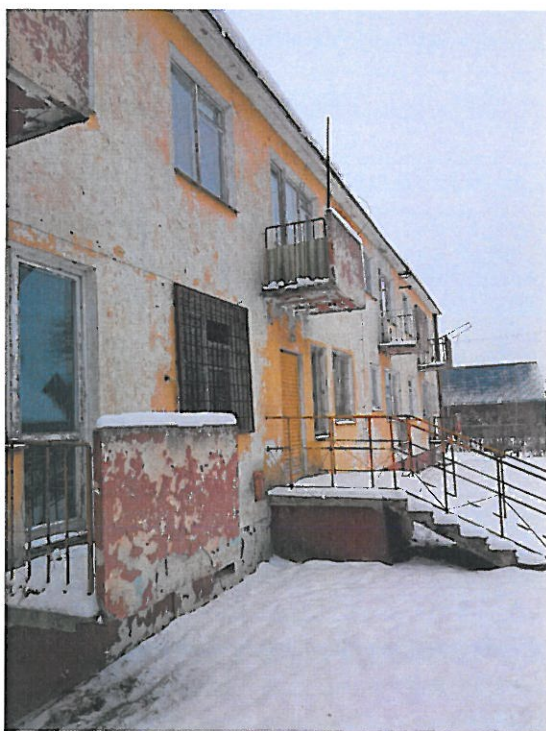
Fot. 2. Elewacja budynku
