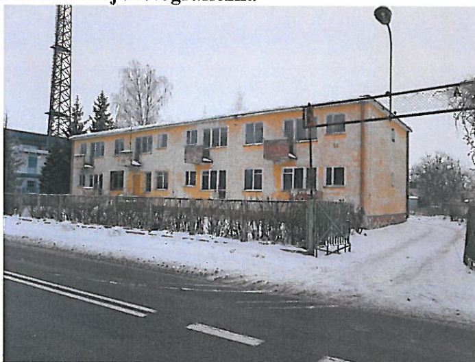
Fot. 1. Elewacja budynku
