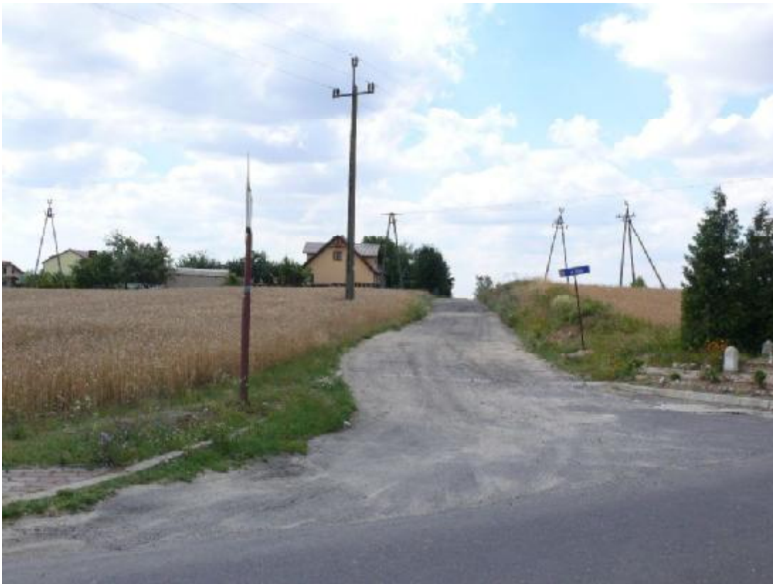
fot. - stan istniejący
