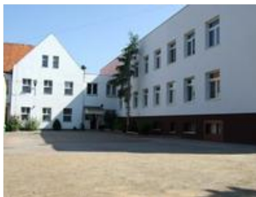
Widok od strony boiska (rys.4)
