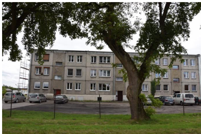
Fot. 2. Budynek mieszkaniowy wielorodzinny w Przybychowie
