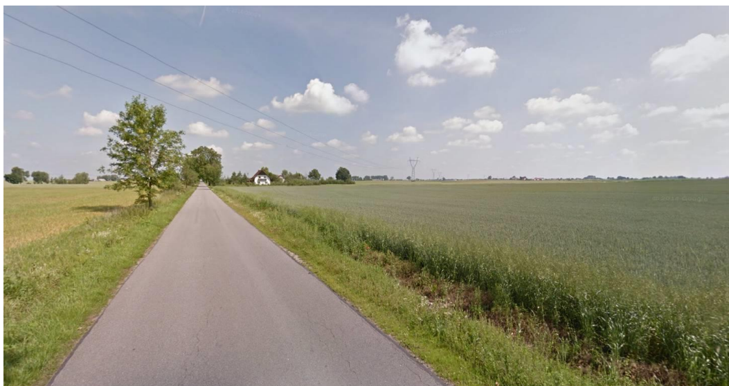
Fot. 3 Istniejąca linia 220 kV na północ od Papowa Biskupiego
