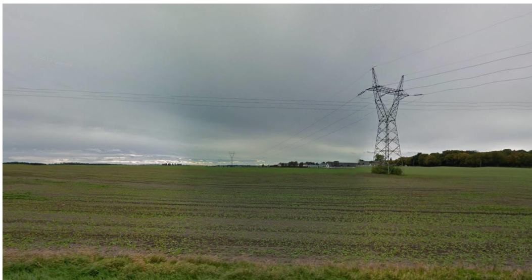
Fot. 1 Widok z drogi krajowej nr 91 w kierunku południowo-zachodnim
