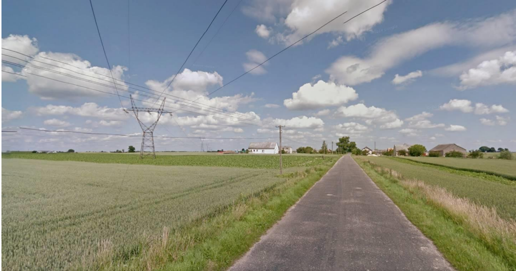
Fot. 4 Istniejąca linia 220 kV na zachód od Nowego Dworu Królewskiego
