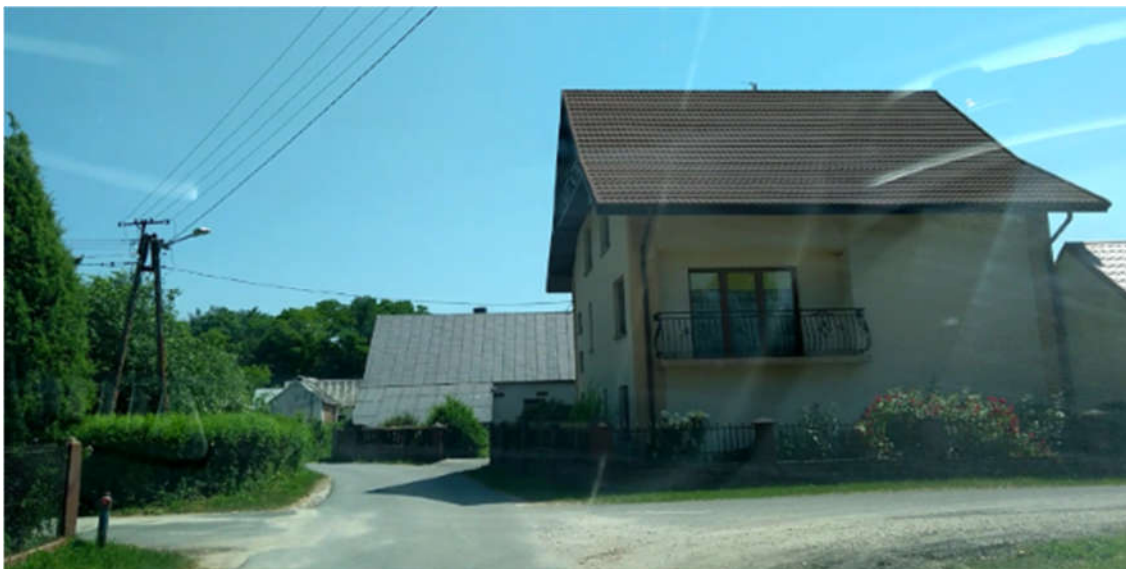
Koniec projektowanego odcinka w km ~0+325 – skrzyżowanie z drogami gminnymi. Na słupie po lewej stronie będzie wykonany przyłącz zasilania oświetlenia ulicznego
