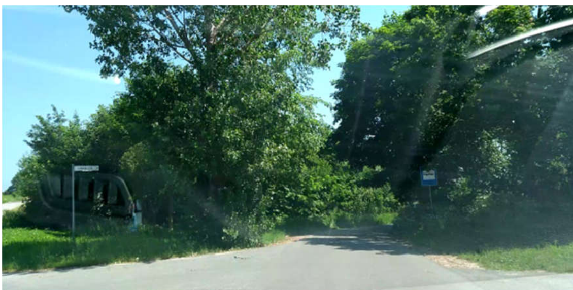
Początek robót – w km ~0+015
