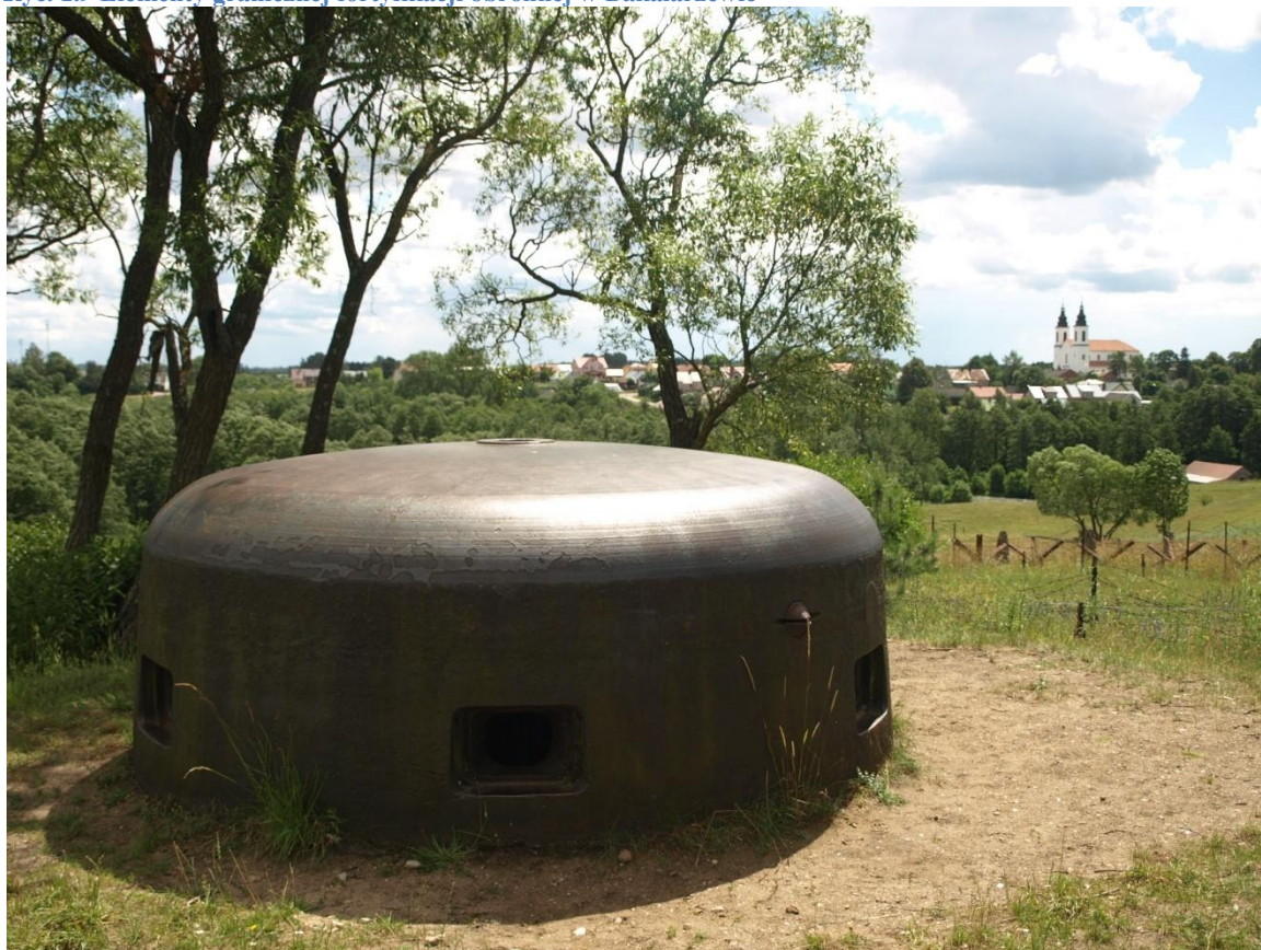
Ryc. 1.9 Elementy granicznej fortyfikacji obronnej w Bakalarzewie
