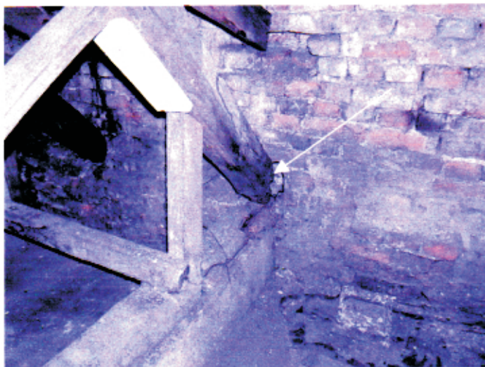
fot.5 Oparcie krokwi na murze (strzałka wskazuje końce krokwi do wzmocnienia lub wymiany)
