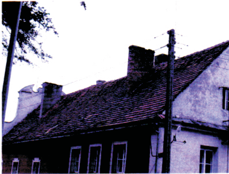
fot.1 Widok dachu od strony ulicy
