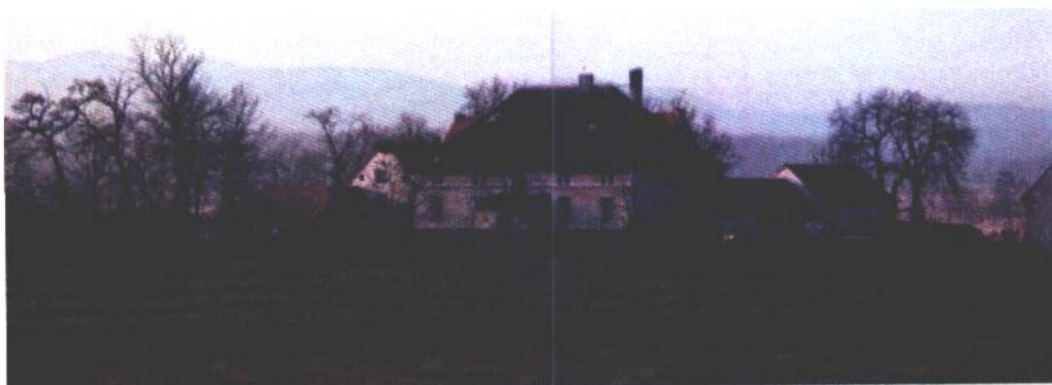
Rys. 1. Stare zabudowania w centrum wsi.
