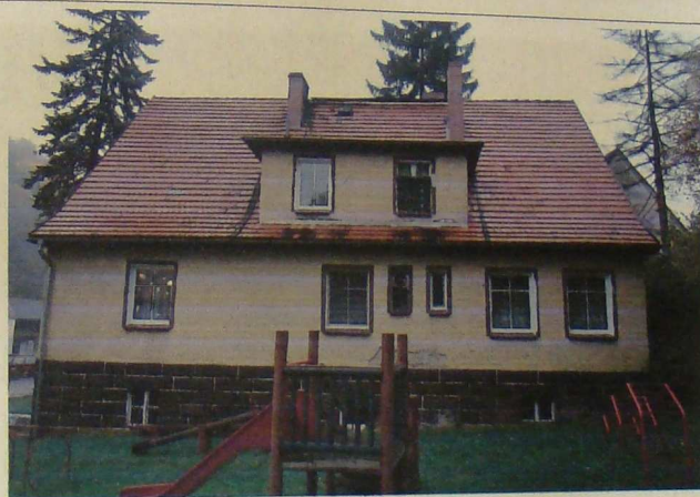
Fot.2 Widok od strony podwórza
