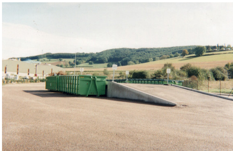
Rys. 9 Rampa wyładownicza zlokalizowana na terenie PDGO
