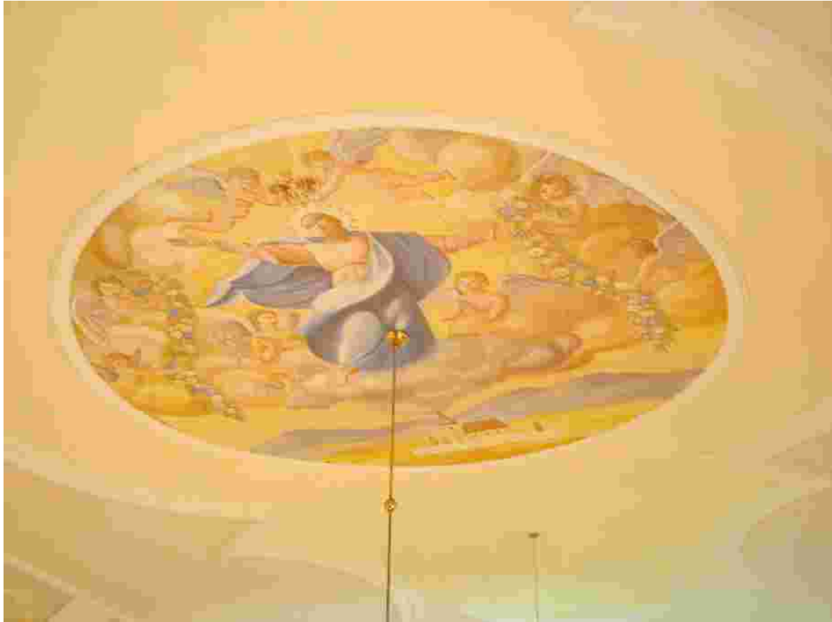
Fot.10 Plafon na suficie.
