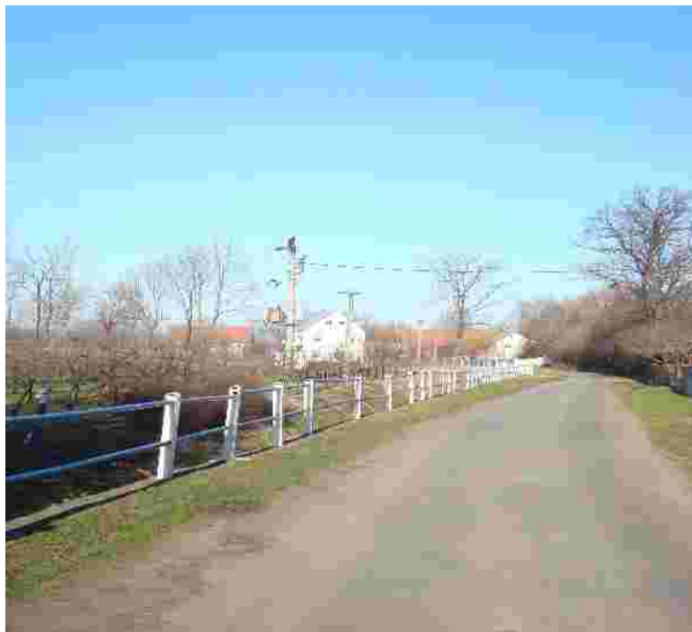
Fot. 2 Droga w Plonicy wzdłuż rzeki Swida.
