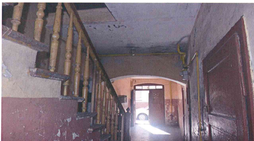
Fotografia 14 Klatka schodowa budynku mieszkalnego na ul. J. Słowackiego (opr. własne).
