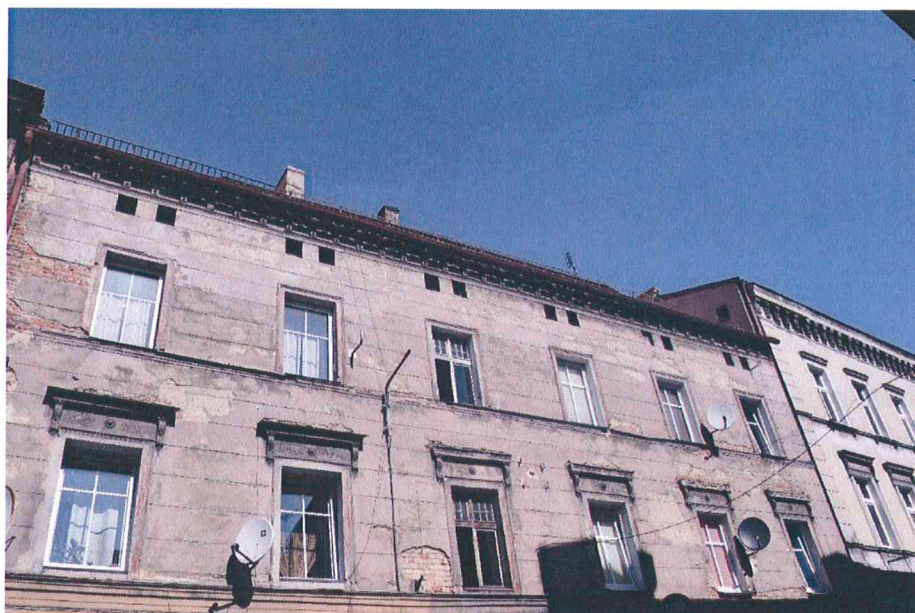
Fotografia 7 Zdegradowana elewacja budynków mieszkalnych (opr. własne)
