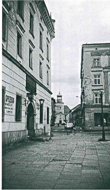
Fotografia 11 Zły stan infrastruktury chodników – Rynek w Ziębicach (opr. własne).
