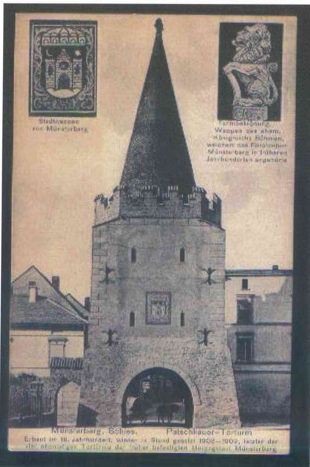
Dekoracja od strony elewacji zewnętrznej
