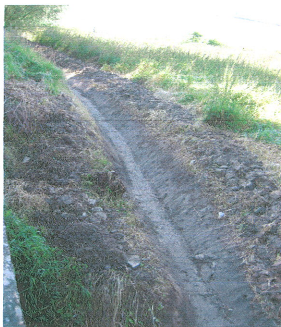
Fot. nr 15. Rów melioracji szczegółowej - po zabiegach konserwacyjnych
