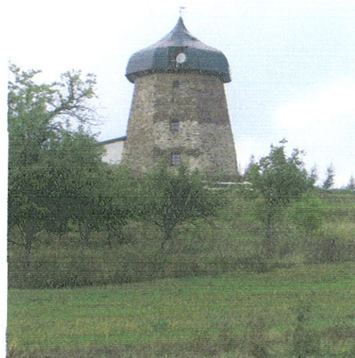
Fot. nr 21. Zabytkowy wiatrak w Bożnowicach
