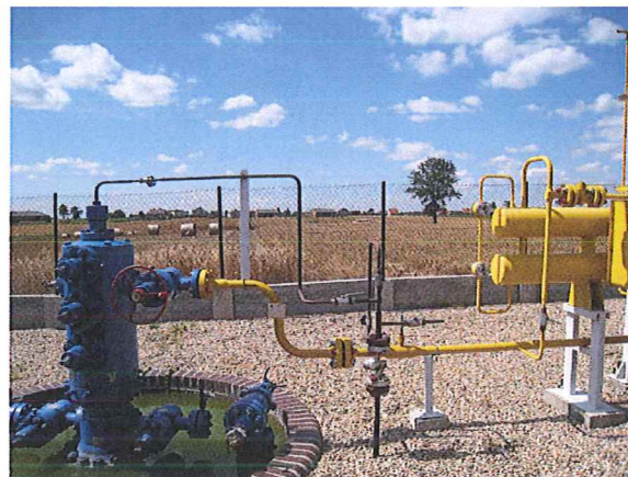
Przykład instalacji dozowania metanolu
