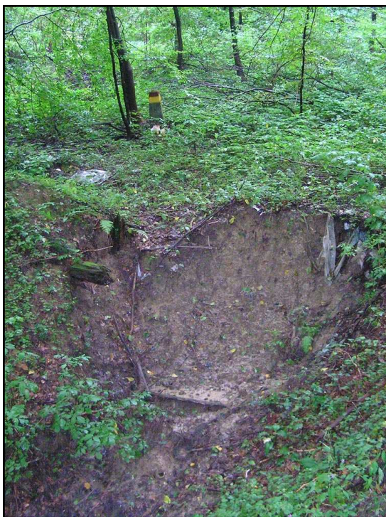
Fot.10 Osunięcie w leju źródłiskowym w sąsiedztwie linii istniejącego gazociągu – wschodnia część opracowywanego obszaru.
