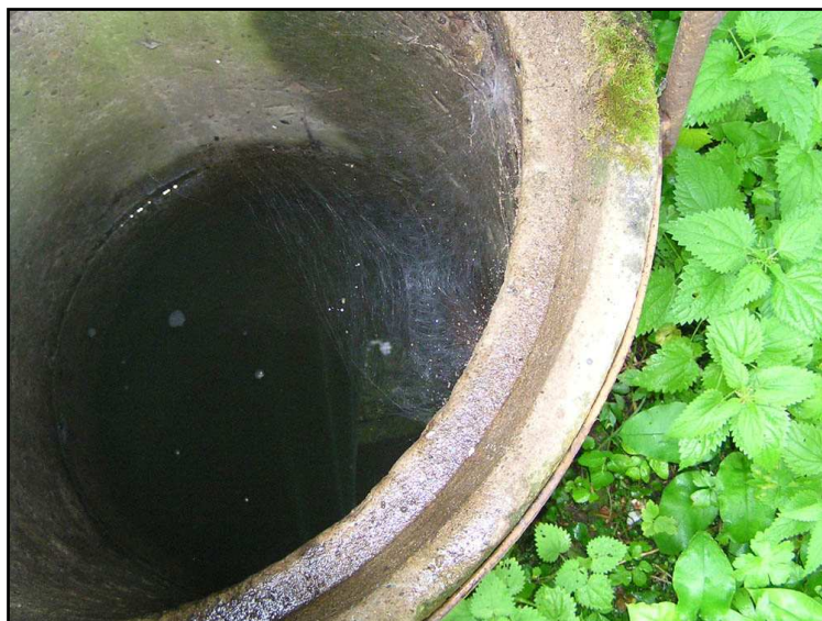
Fot. 13 Studnia gospodarcza zlokalizowana w północnej części miejscowości Jaćmierz. Poziom zwierciadła wody po intensywnych pięciodniowych opadach ustabilizowany około 30 cm poniżej powierzchni terenu.
