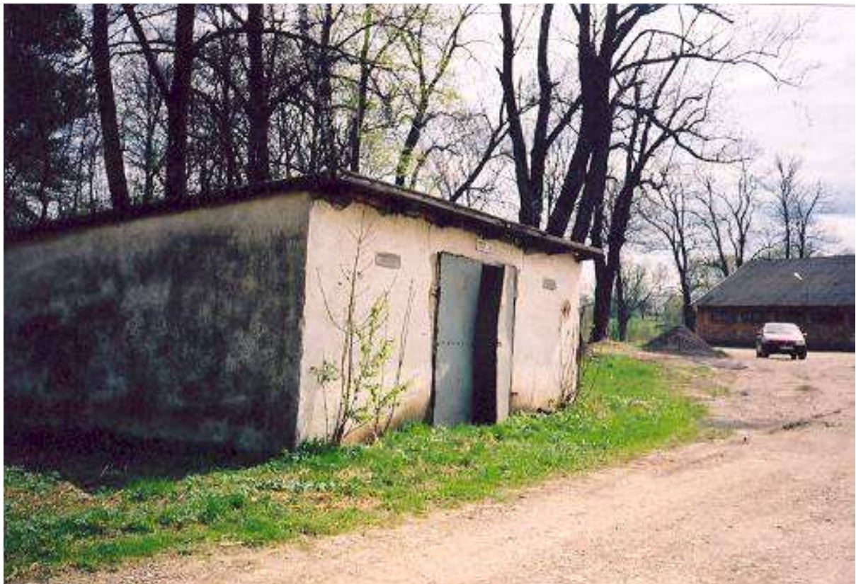
Budynek składowy paliw
