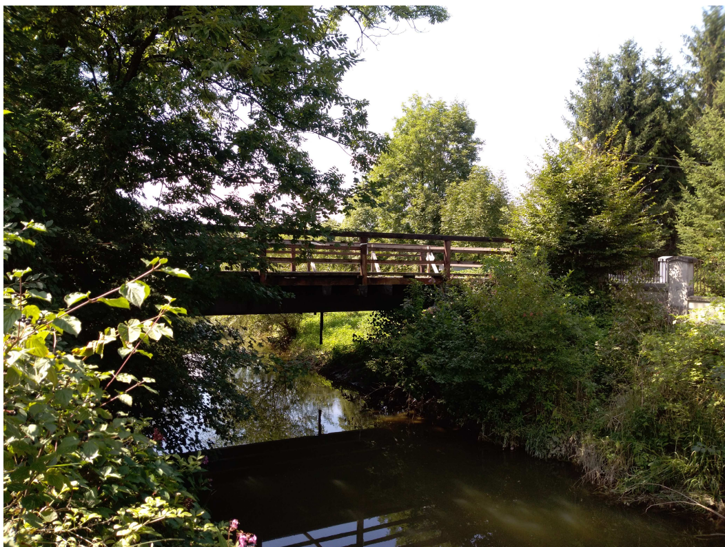
Fot.4 Widok mostu od strony górnej wody
