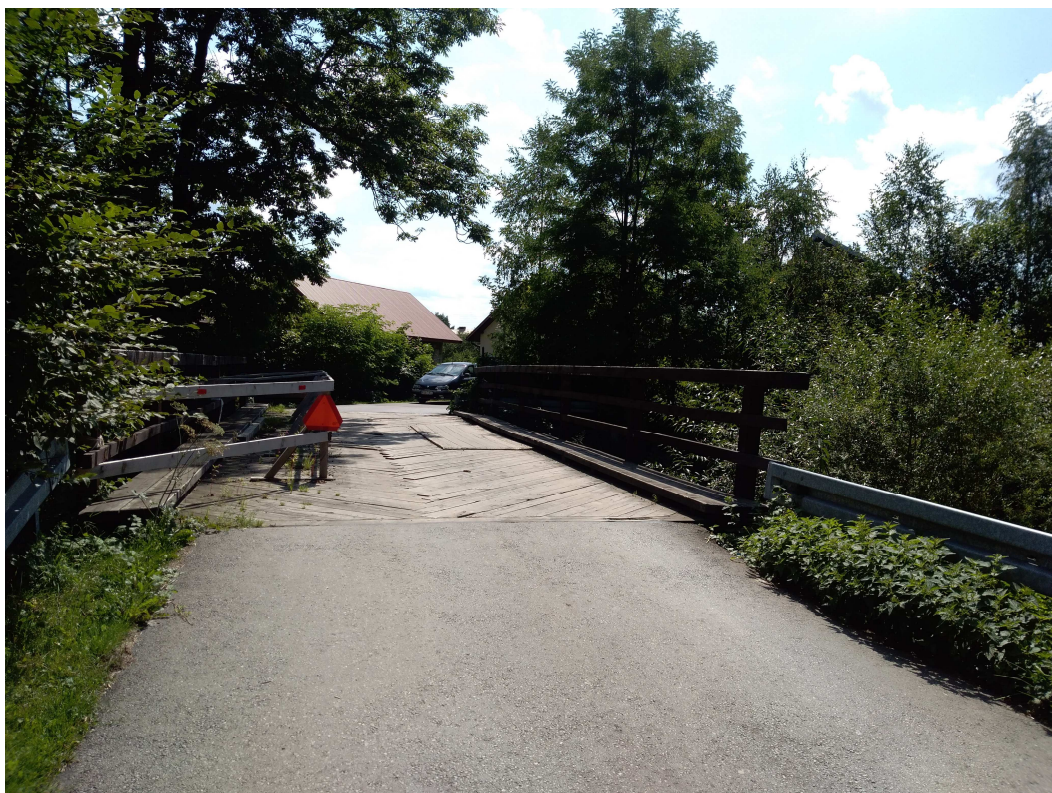
Fot.2 Widok mostu od strony DK28
