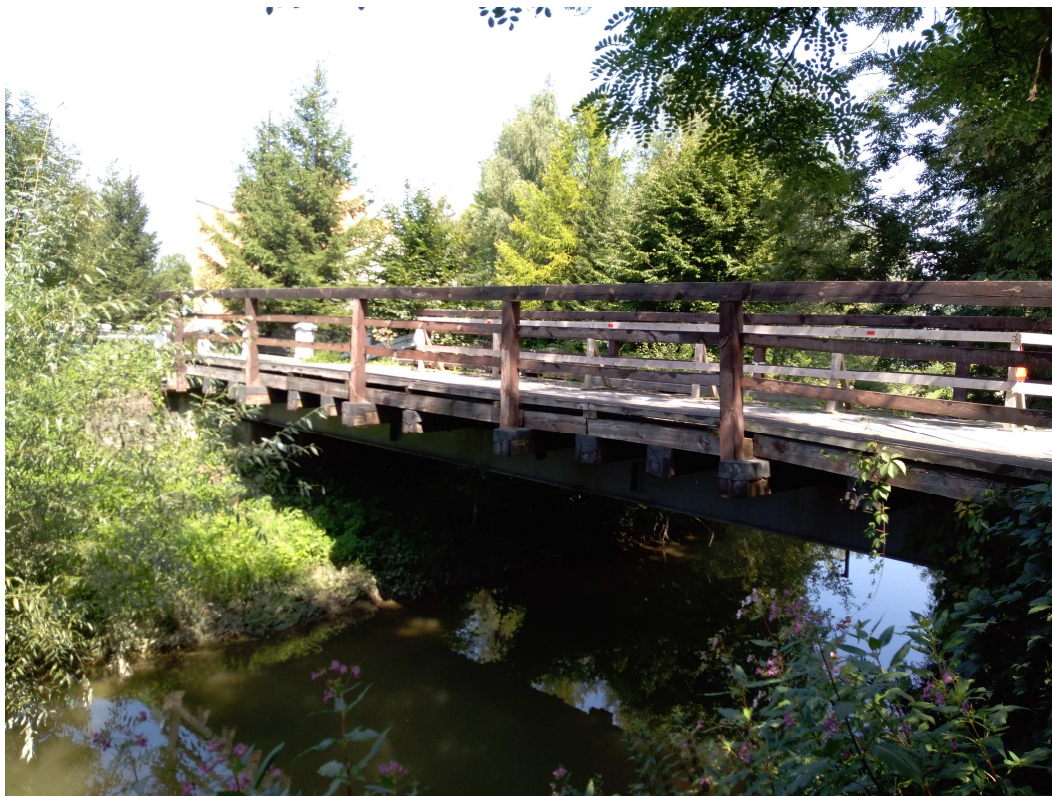
Fot.3 Widok mostu od strony dolnej wody
