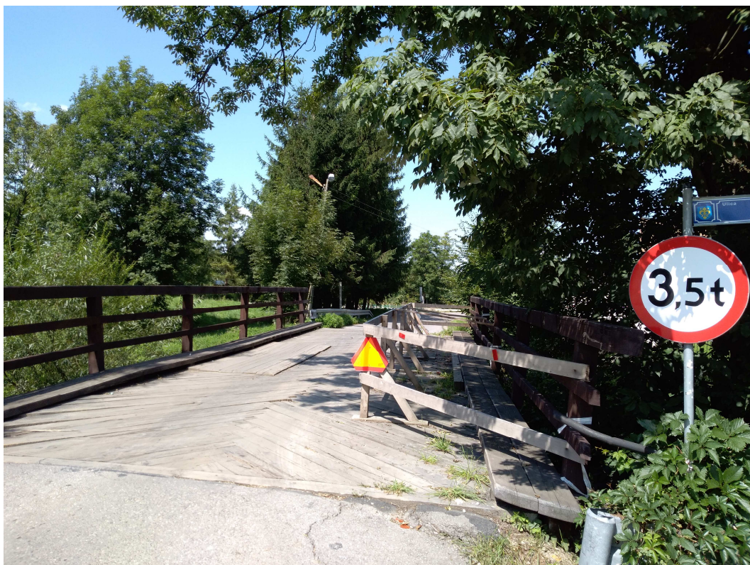
Fot.1 Widok mostu od strony ul Południowej
