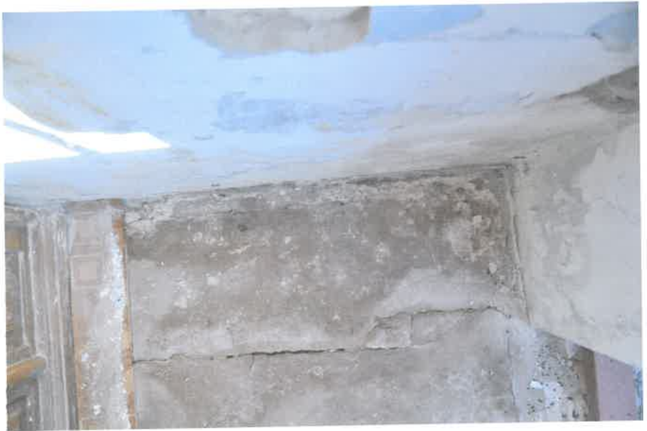
Fot. 18 Kapliczka przydrożna z przełomu XIX i XX wieku w Dzierdźiówce Stan przed konserwacją Widok posadzki kapliczki z pęknięciem i śladami zagrzybienia styczeń 2018 r.
