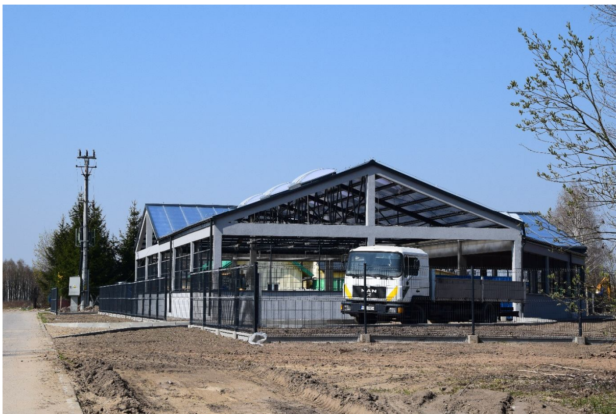
Nowa wiata na osad przy oczyszczalni ścieków w Kępie Zaleszańskim
