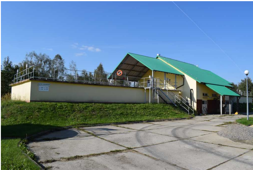
Fot. 40. Oczyszczalnia ścieków w Kępie Zaleszańskim
