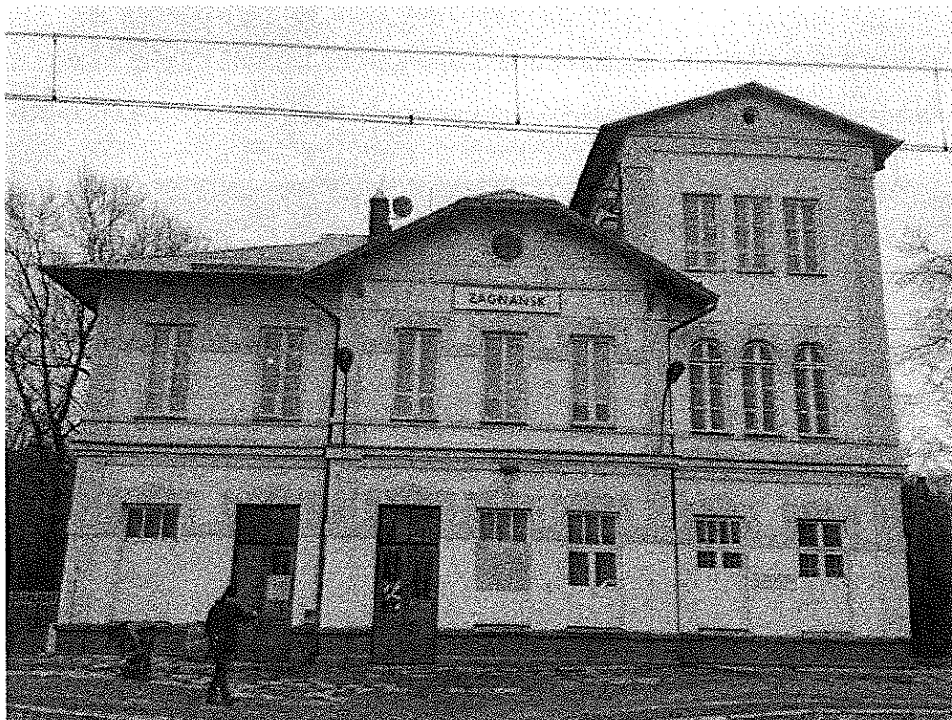
Zagnańsk, budynek Dworca PKP – potrzeba zagospodarowania obiektu, który utracił swoje dotychczasowe funkcje ( https://www.panoramio.com/user/5686175?with_photo_id=113923276 )
