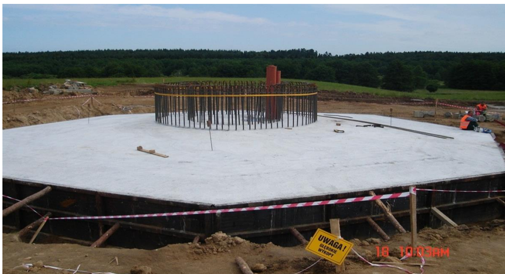
Rycina 5. Budowa fundamentu (przykład nie dotyczy realizowanej instalacji)
