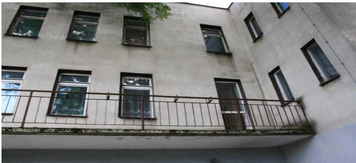
Fot. 9. Nieczynny obiekt Budynku Socjalno-Użytkowego z Bazą Noclegowo-Wypoczynkową (ul. Parkowa)
