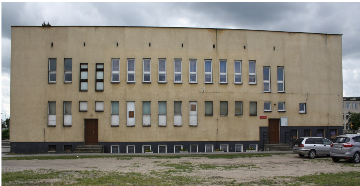
Fot. 24. Budynek Domu Kultury (ul. XX-lecia)
