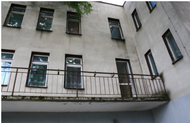
Fot. 9. Nieczynny obiekt Budynku Socjalno-Użytkowego z Bazą Noclegowo-Wypoczynkową (ul. Parkowa)
