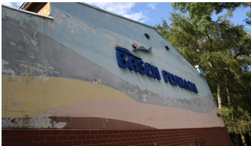
Fot. 10. Nieczynny obiekt Basenu Pływackiego (ul. Parkowa)
