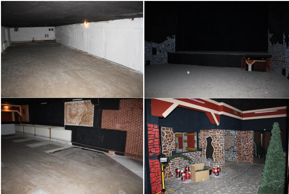
Fot. 25. Niewykorzystywane, częściowo zdegradowane pomieszczenia w piwnicach Domu Kultury – część 1.
