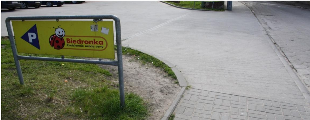
Fot. 14. Brak przejścia dla pieszych przy wjeździe do Biedronki (ul. Parkowa)
