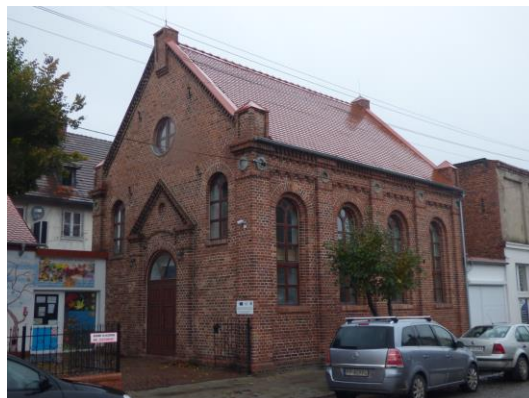
Fot. 17. Synagoga w Wyrzysku Źródło: fotografia własna
