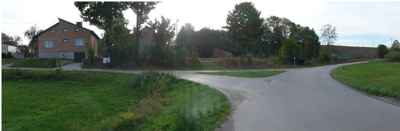
Zdjęcie 65 Drogi lokalne w sołectwie Przyłęczek. Fot. GRACZKOWSKI DOTACJE Sp. z o.o., październik 2015.
