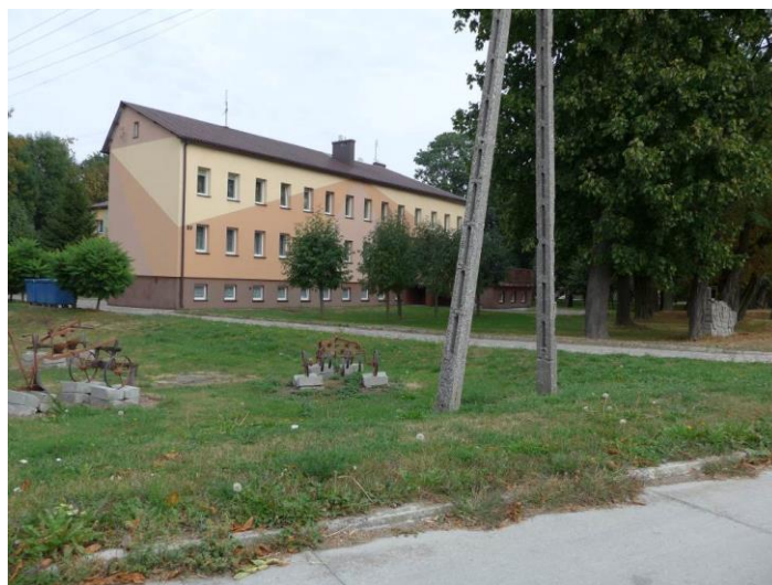
Zdjęcie 70. Blok mieszkalny w Przewodach. Fot. GRACZKOWSKI DOTACJE Sp. z o.o., wrzesień 2015r.
