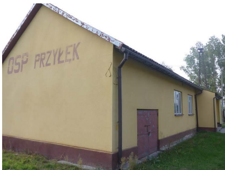
Zdjęcie 64 Budynek Ochotniczej Straży Pożarnej w Przyłęku. Fot. GRACZKOWSKI DOTACJE Sp. z o. o., październik 2015.
