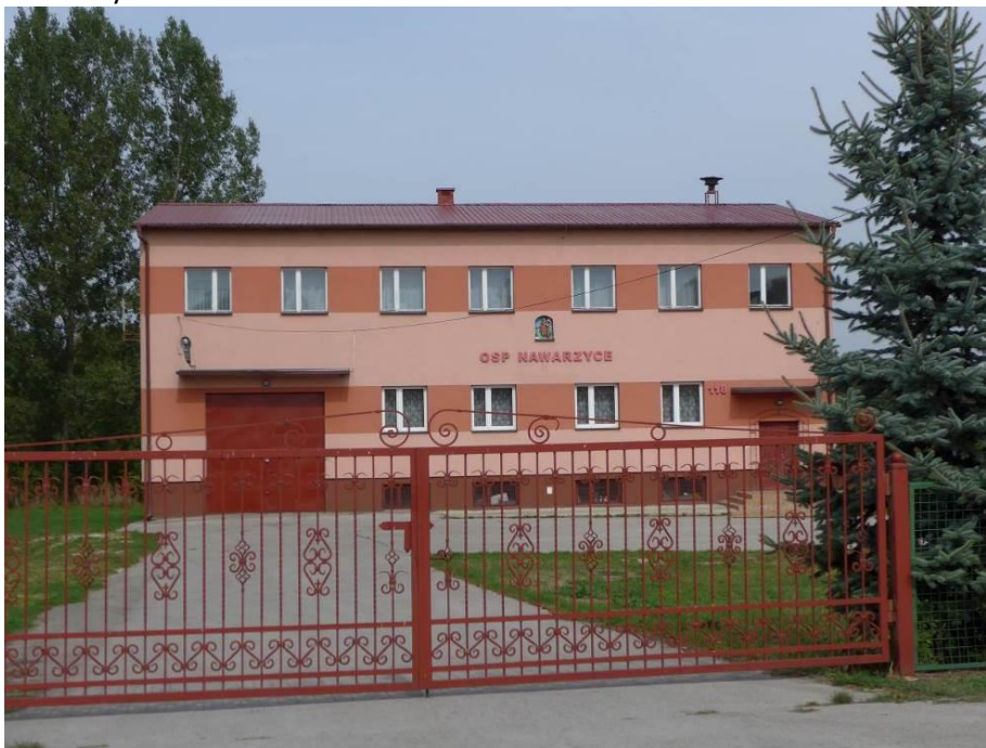
Zdjęcie 44. Budynek remizy OSP w Nawarzacach. For. GRACZKOWSKI DOTACJE Sp. z o.o., wrzesień 2015r.
