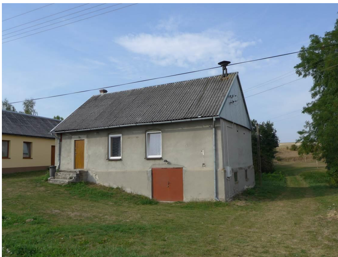
Zdjęcie 39 Budynek Ochotniczej Straży Pożarnej w Laskowej. Fot. GRACZKOWSKI DOTACJE Sp. z o.o., październik 2015.
