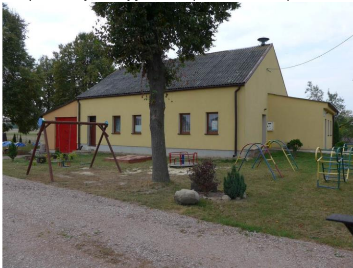
Zdjęcie 69. Remiza Ochotniczej Straży Pożarnej i świetlica wiejska w Przewodach. Fot. GRACZKOWSKI DOTACJE Sp. z o.o., wrzesień 2015r.
