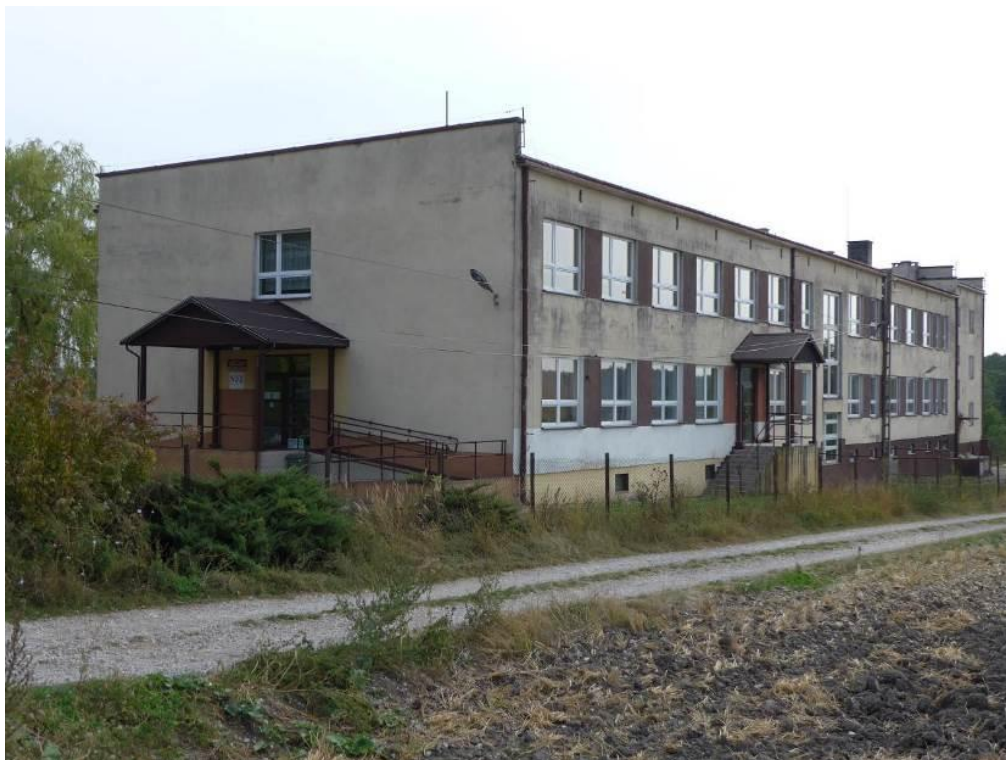
Zdjęcie 49. Budynek Szkoły Podstawowej i Filii Gminnego Ośrodka Zdrowia w Niegosławicach. Fot. GRACZKOWSKI DOTACJE Sp. z o.o., wrzesień 2015r.
