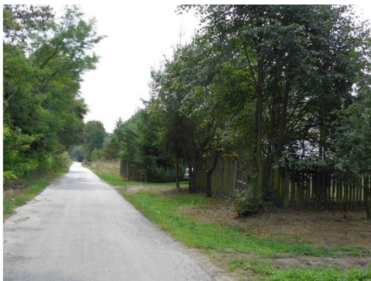
Zdjęcie 72. Droga w miejscowości Podlesie. Fot. GRACZKOWSKI DOTACJE Sp. z o.o., wrzesień 2015r.
