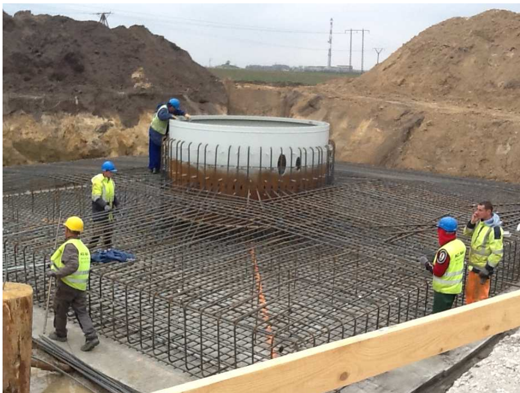
Fot 1. Przykładowy wykop oraz zbrojenie fundamentu elektrowni wiatrowej. źródło: http://www.pew.com.pl
