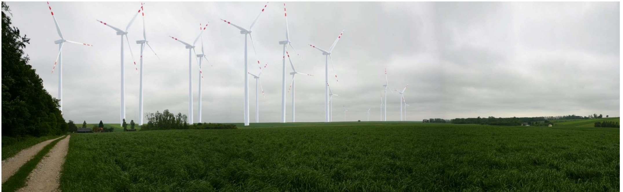
Fot. 5 Widok na zachodnią część terenu lokalizacji Farmy Wiatrowej „Wodzisław” z północy, z rejonu wsi Jezioroki – wmontowane sylwety elektrowni wiatrowych (odległość do elektrowni od ok. 1 km do ok. 4,5 km)
