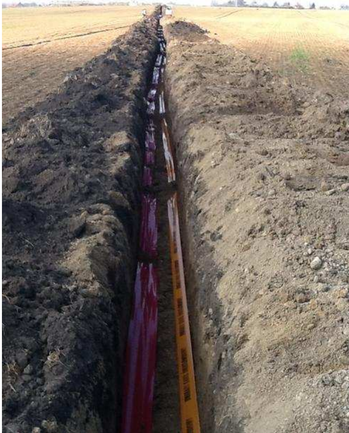
Fot. 2 Przykładowy wykop pod kabel elektroenergetyczny SN źródło: http://www.pew.com.pl
