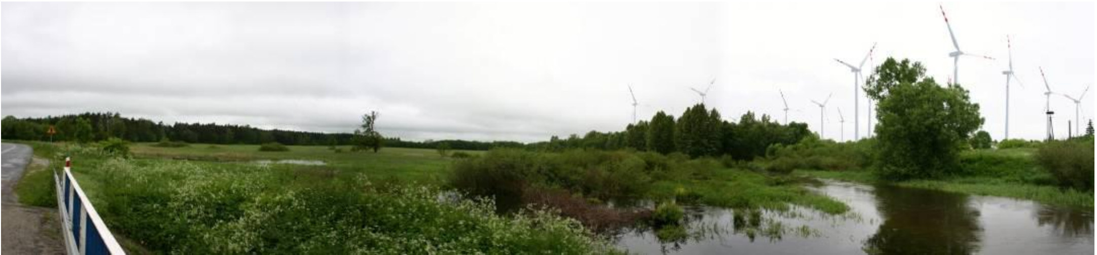
Fot. 8 Widok w kierunku obszaru „Planu...” z mostu na Mierzawie w Niegosławicach – wmontowane sylwety elektrowni wiatrowych (odległość do elektrowni od ok. 1,6 km do ok. 4,6 km)
