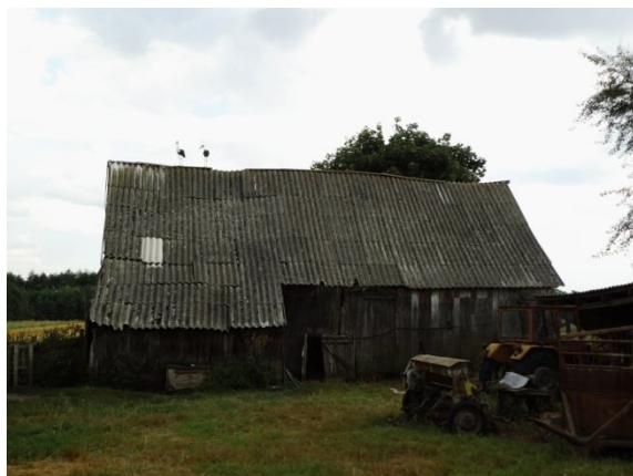
Rys. 1. Pokrycia dachowe zawierające azbest: płyty faliste (po lewej) oraz płaskie (po prawej).
