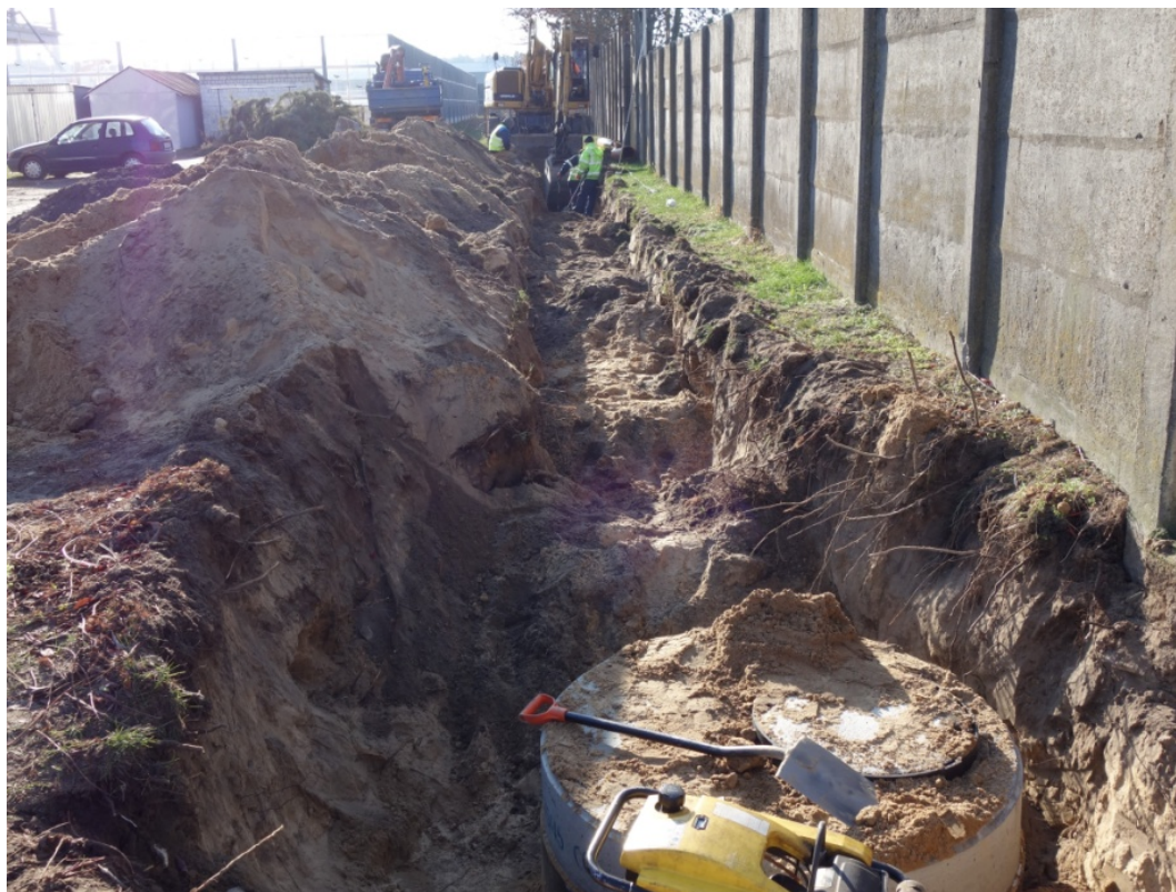
Budowa kanalizacji deszczowej w Starym Gostkowie
