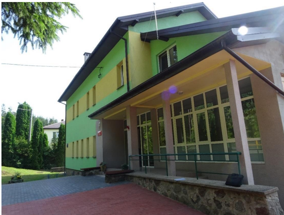
Rysunek 2. Widok ocieplonej części budynku od strony wejścia głównego.
