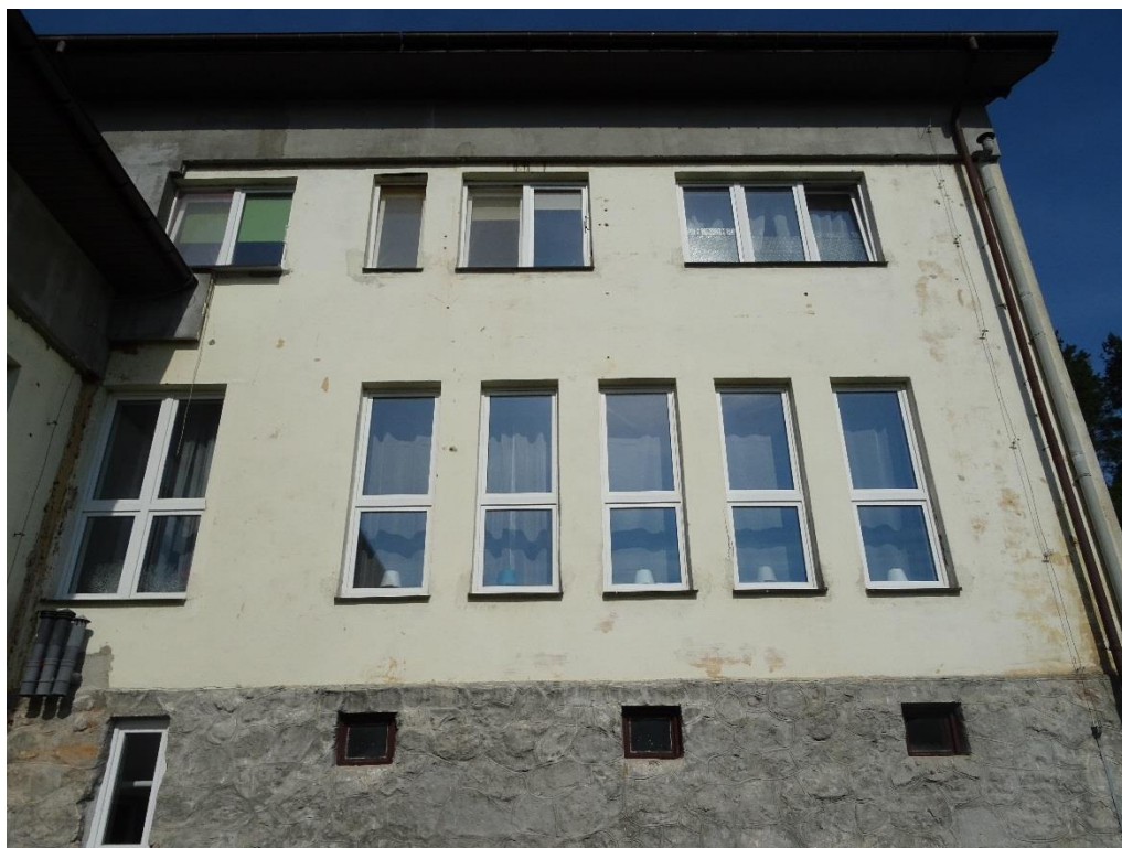
Rysunek 4. Widok elewacji tylnej przed termomodernizacją.
