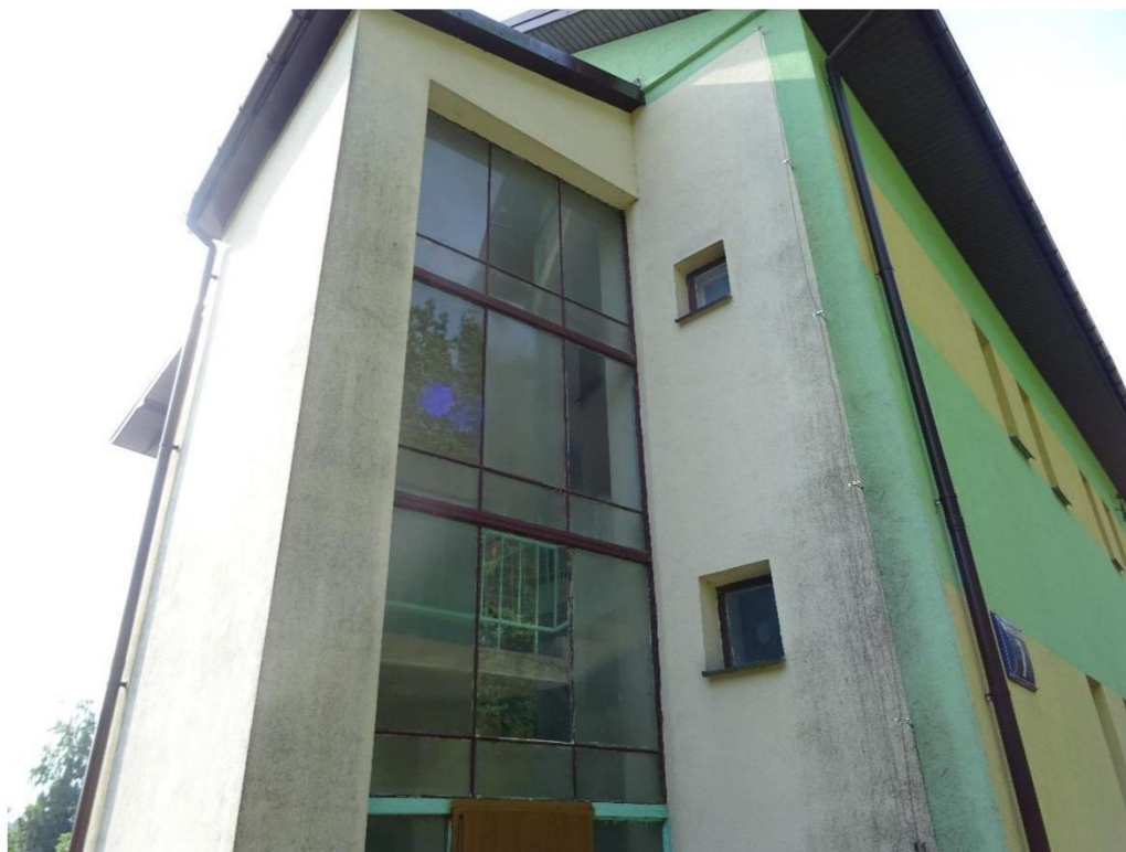
Rysunek 5. Widok klatki schodowej przed termomodernizacją.
