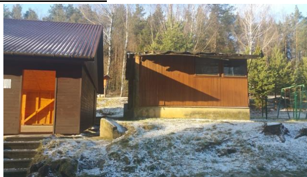
Fot. Widok na elewację południowo-wschodnią
