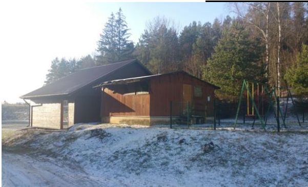
Fot. Widok na elewację wschodnią
