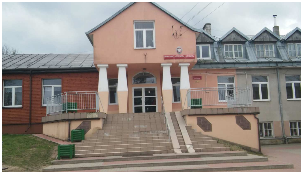
Fot 1 Widok elewacji budynków
