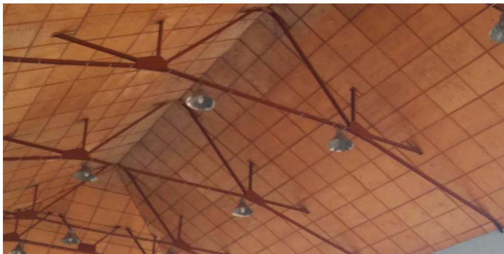
Fot 5 Widok konstrukcji dachu stalowego
