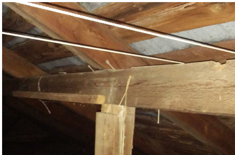
Fot 4 Widok konstrukcji dachu drewnianego
