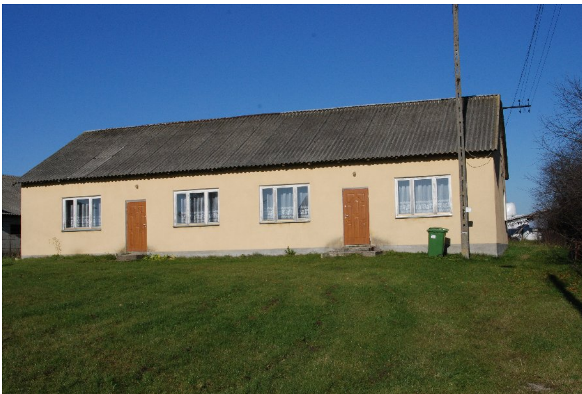
Budynek przewidziany do rozbudowy i przebudowy pod kątem prowadzenia świetlicy.
