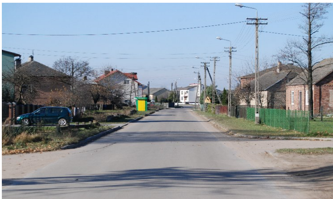
2009 r. – zniszczenia po huraganie zostały w większości naprawione.
