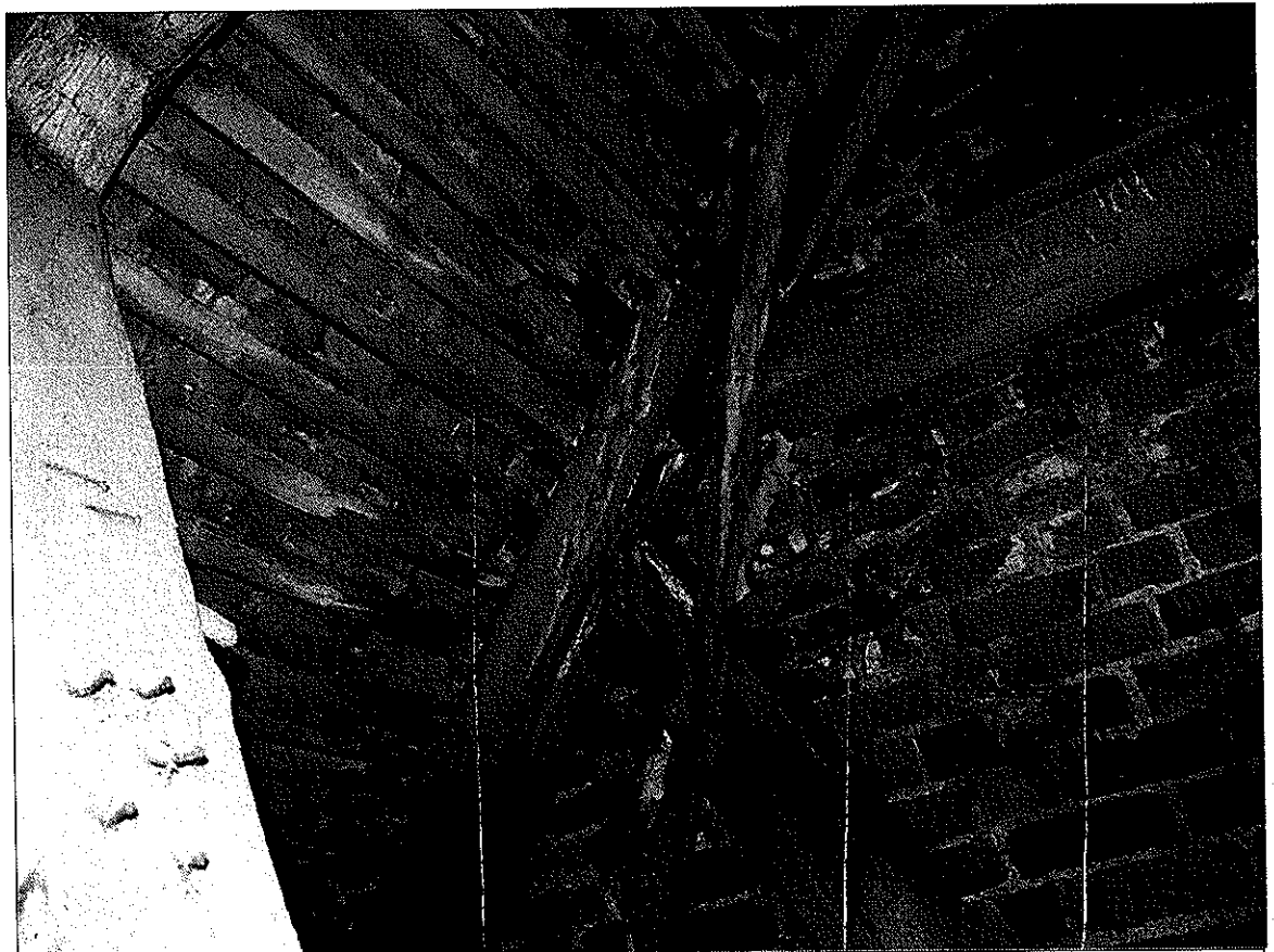
FOTO 9 SZCZEGÓŁ USZKODZONEGO WĘZŁA KONSTRUKCYJNEGO ORAZ KROKWI w ZABYTKOWEJ BRAMIE KAMIENNEJ w ŚWIDWINIE ze zbiorów archiwum własnego autora opracowania stan z maja 2009. str. 16
