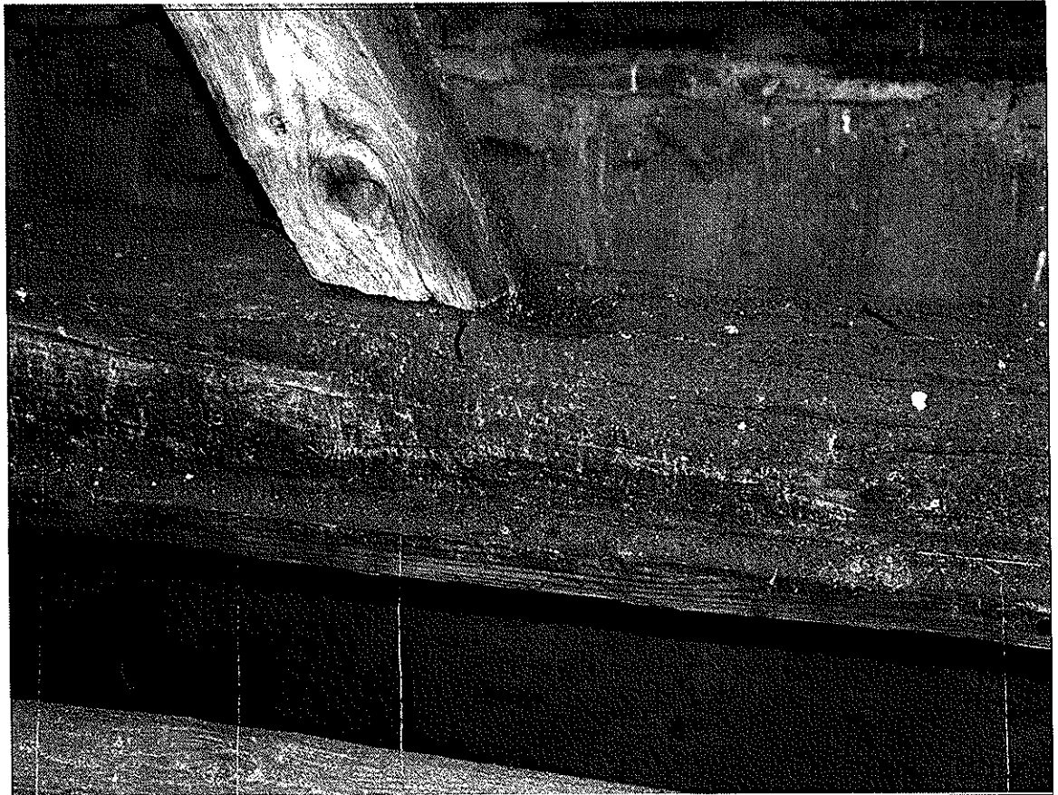
FOTO 11 PRZYKŁAD MIEJSCOWEGO USZKODZENIA WĘZŁA KONSTRUKCYJNEGO w STYKU ZASTRZAŁU Z BELKĄ STROPOWĄ w ZABYTKOWEJ BRAMIE KAMIENNEJ w ŚWIDWINIE stan z maja 2009. ze zbiorów archiwum własnego autora opracowania
