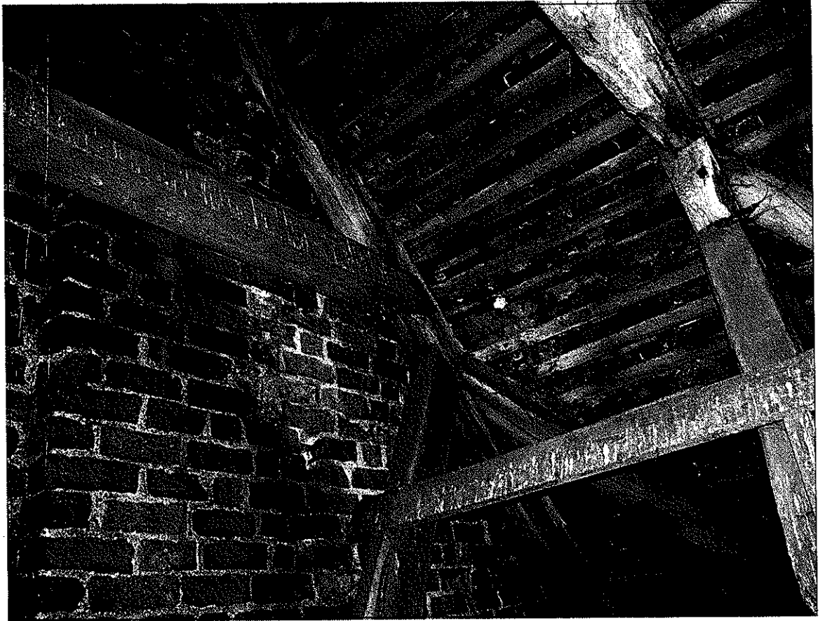
FOTO 8 SZCZEGÓŁ USZKODZONEGO WĘZŁA KONSTRUKCYJNEGO W STYKU JĘTKI Z KROKWIĄ w ZABYTKOWEJ BRAMIE KAMIENNEJ w ŚWIDWINIE ze zbiorów archiwum własnego autora opracowania stan z maja 2009.
