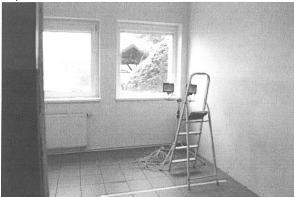
Zdjęcie 1. Remont pomieszczeń.
