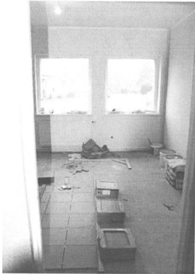
Zdjęcie 2. Remont pomieszczeń.
