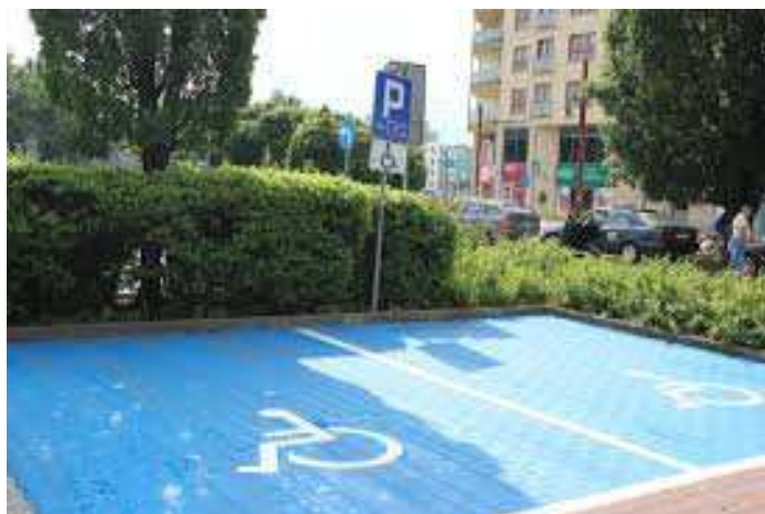
Zdj. nr 1 Malowanie nawierzchni miejsc postojowych dla osób niepełnosprawnych
