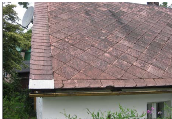
Fot. 2 Płyty azbestowo-cementowe płaskie
