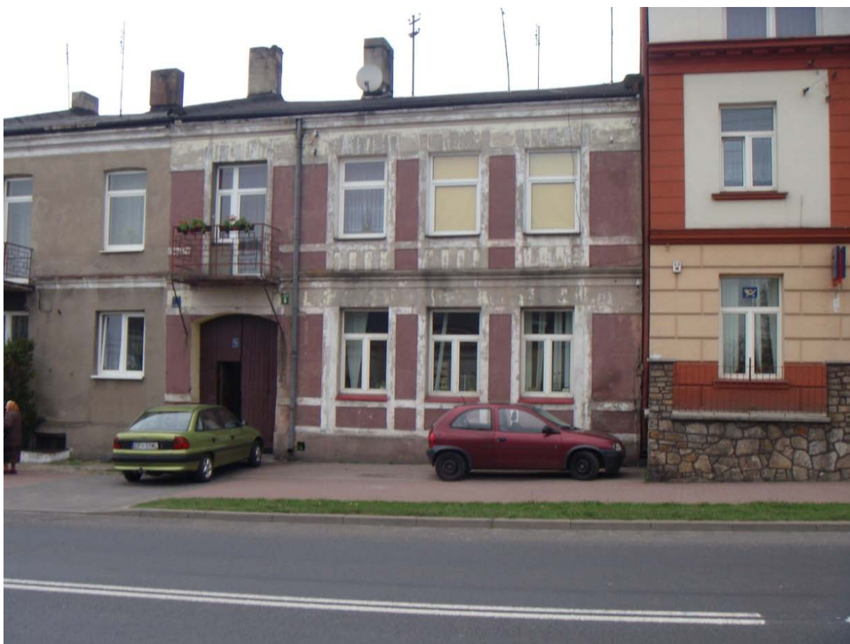
Obiekt na ul. Koneckiej 5 w Sulejowie wymagający podjęcia prac rewaloryzacyjnych
