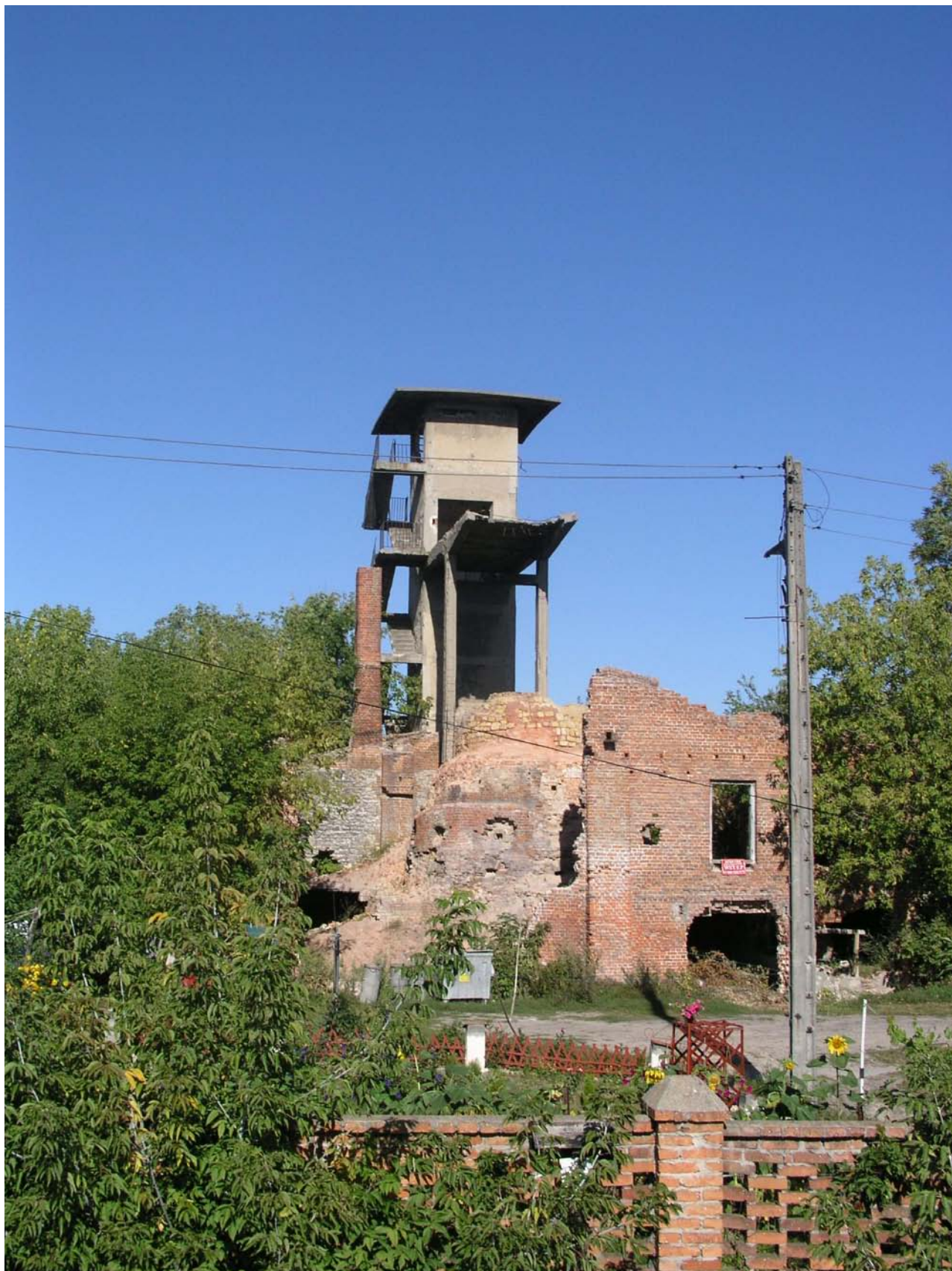
Wapienniki przeznaczone do przeprowadzenia prac konserwatorskich
