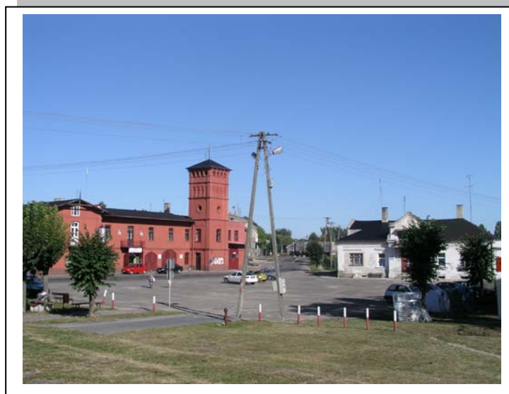
Sulejów – rynek budynek straży przed remontem
