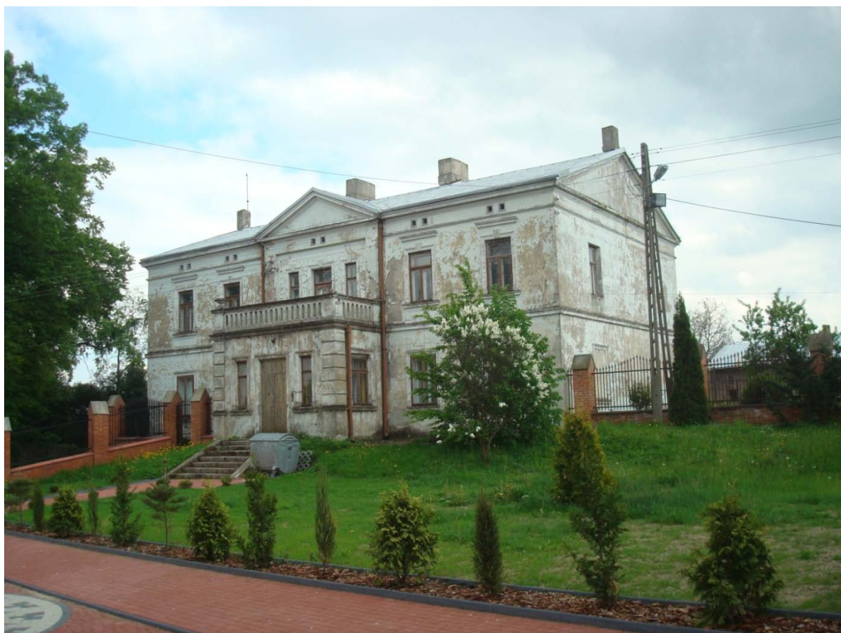
Plebania w Sulejowie wymagająca podjęcia prac konserwatorskich
