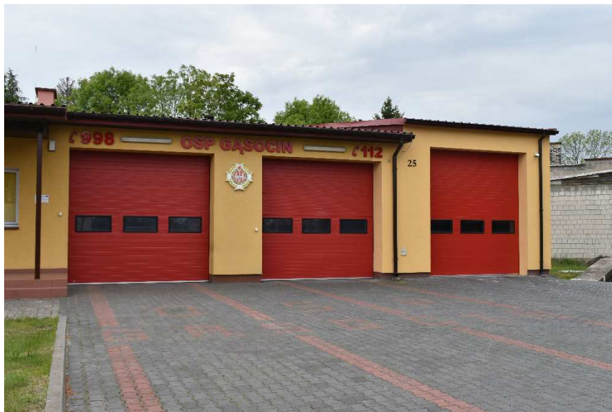
Rozbudowa garażu OSP Gąsocin
