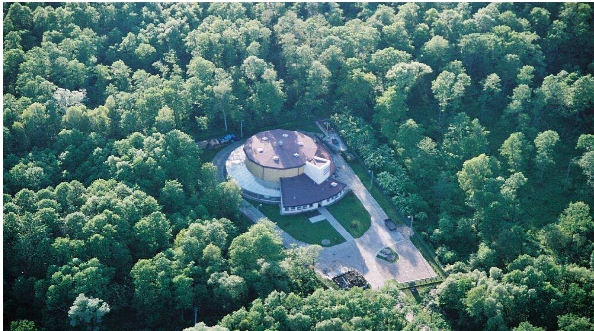
Gminna oczyszczalnia ścieków w Komorach Dąbrownych
