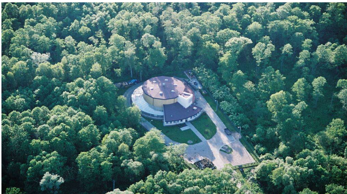
Gminna oczyszczalnia ścieków w Komorach Dąbrownych
