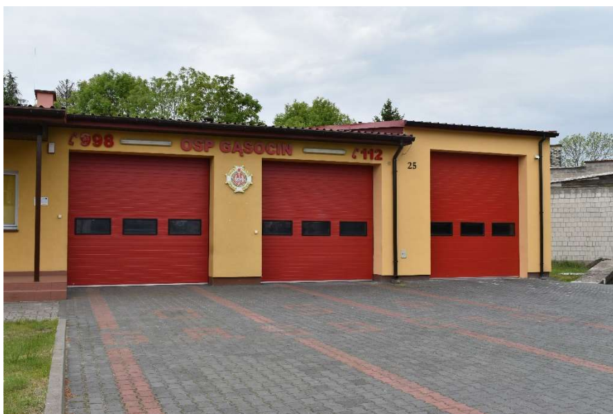
Rozbudowa garażu OSP Gąsocin
