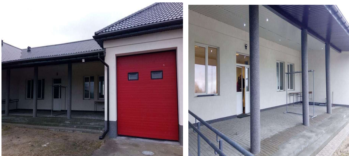
Modernizacja budynku OSP Sarnowa Góra
