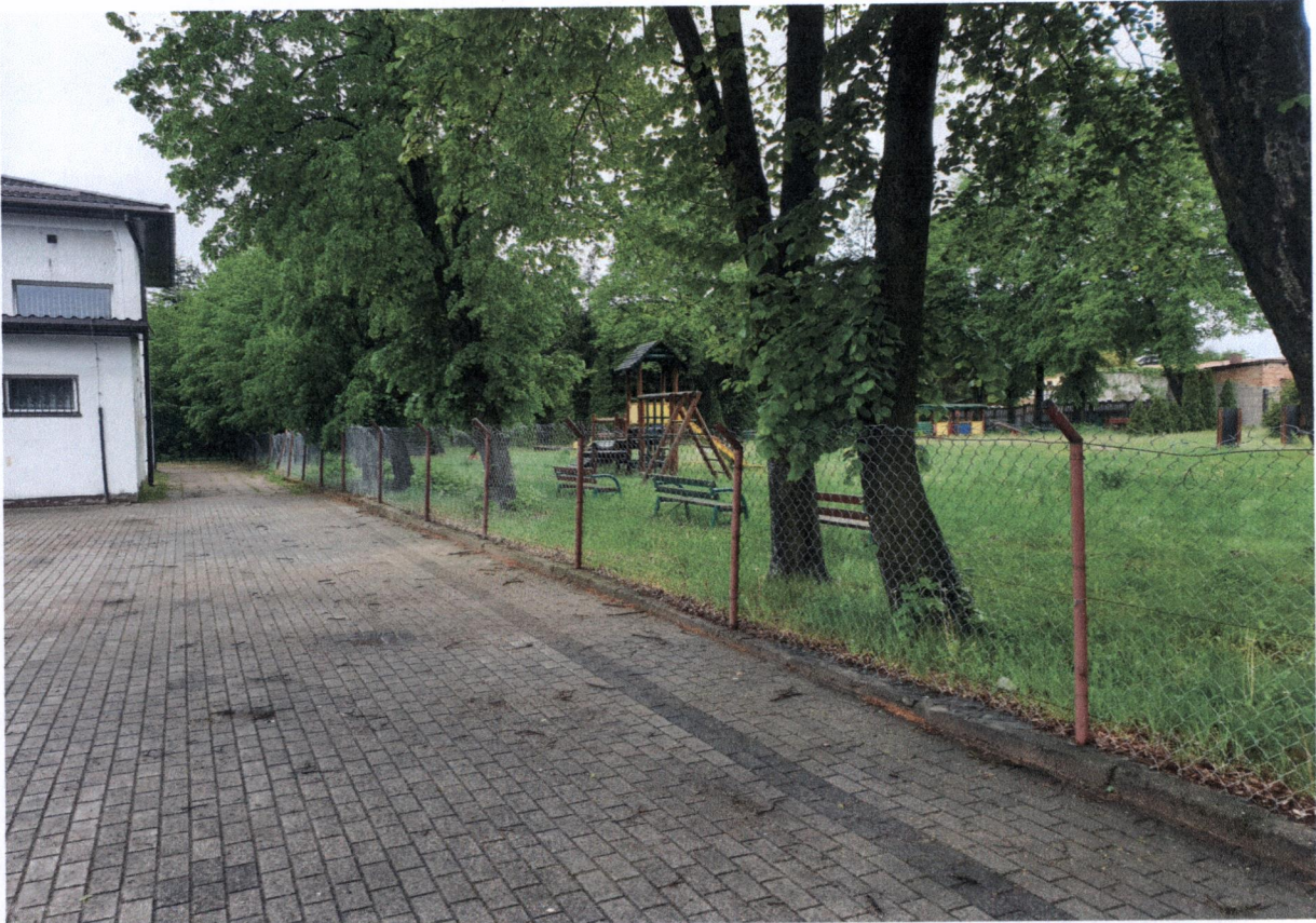
Zdjęcie nr 2 – ogrodzenie od południa do rozbiórki wraz z cokolikiem (od strony budynku szkoły)
