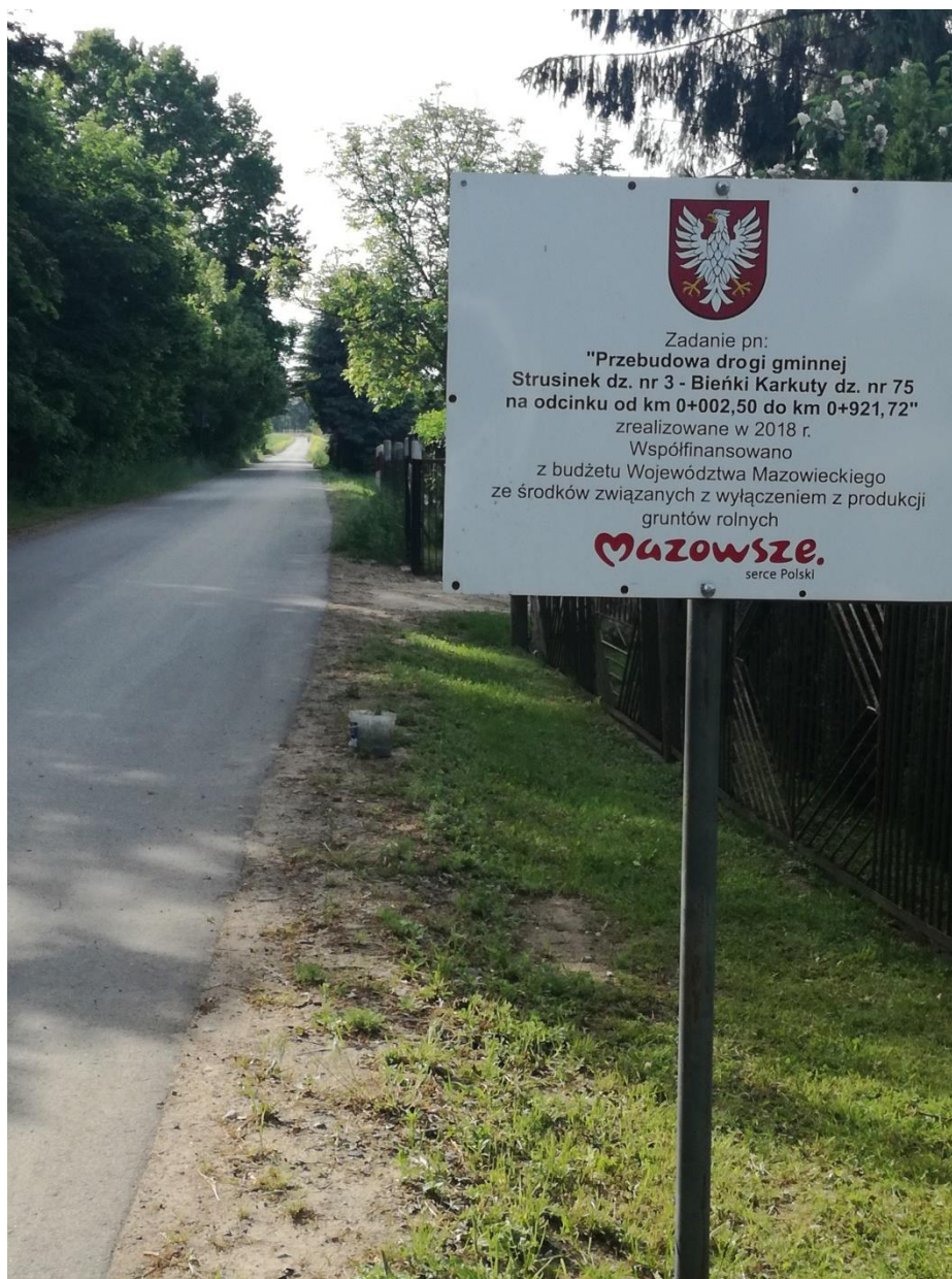
Przebudowa drogi gminnej Strusinek dz. nr 3 – Bieńki Karkuty dz. nr 75 na odcinku od km 0+002,50 do 0+921,72 m
