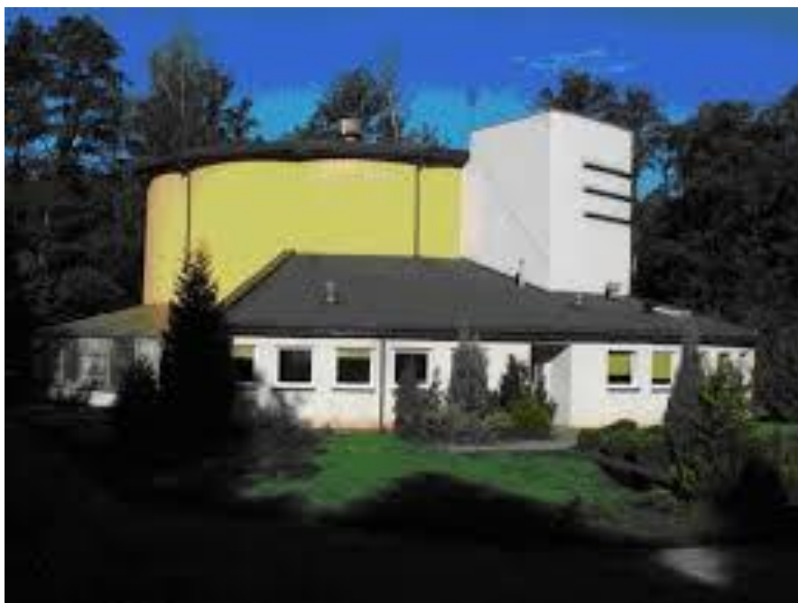
Gminna oczyszczalnia ścieków w Komorach Dąbrownych
