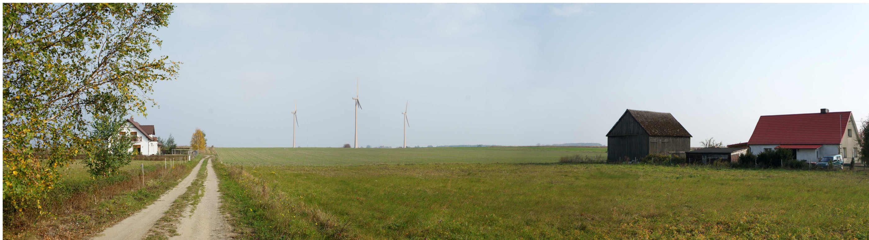
P4 Kolonia pod Lasem, widok w kierunku wschodnim. Zespół elektrowni wiatrowych nie koliduje z krajobrazem kulturowym wsi.
